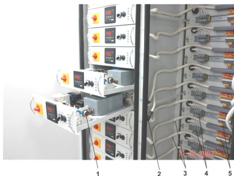
Рис.3 Выкатные модули в выдвинутом положении
