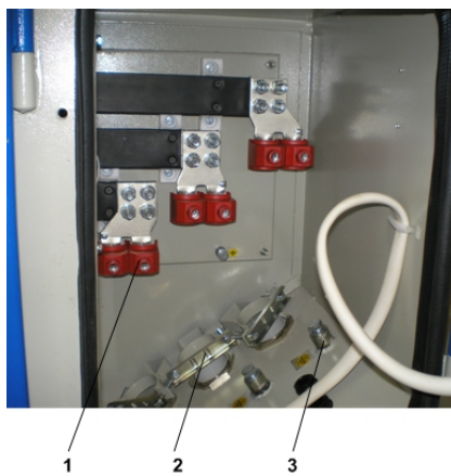
Рис.4 Камера выводов
