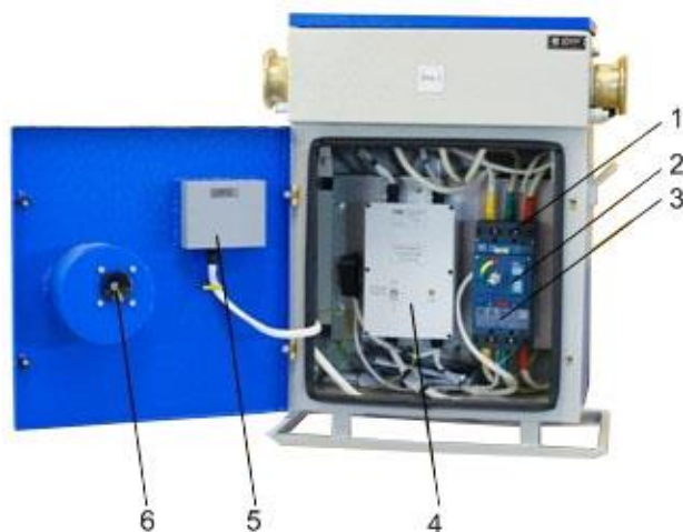
Рис. 19 Общий вид ВР-250ДО с открытой дверцей.
