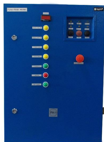
Пульт сигнализации и блокировок главного насоса ПСБУ-1
