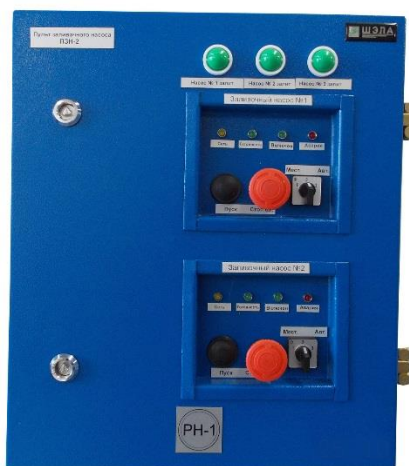
Пульт заливочных насосов ПЗН-2 (на два насоса)
