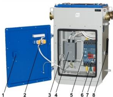
Рис. 10 Вид ВР-250Р-ПП с открытой дверцей (в корпусе повышенной прочности). 1 – скоба для блокировки двери; 2 – панель сигнализации и управления ПСУ-2Ф; 3 – концевой выключатель SQ блокировки двери; 4 – блок управления БУ-2Ф1; 5 – выключатель автоматический; 6 – механизм блокировки привода выключателя с дверью; 7 – уплотнитель резиновый; 8 – рукоятка включения автоматического выключателя.
