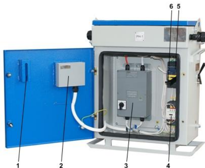
Рис. 2 Камера пускозащитной аппаратуры ПР-63М.
