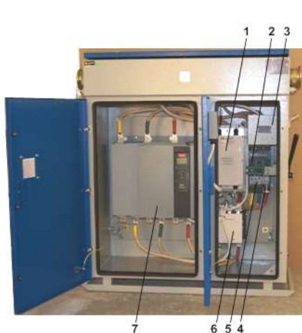
Камеры пускозащитной аппаратуры станции управления СУ-РН-ВМП-250
