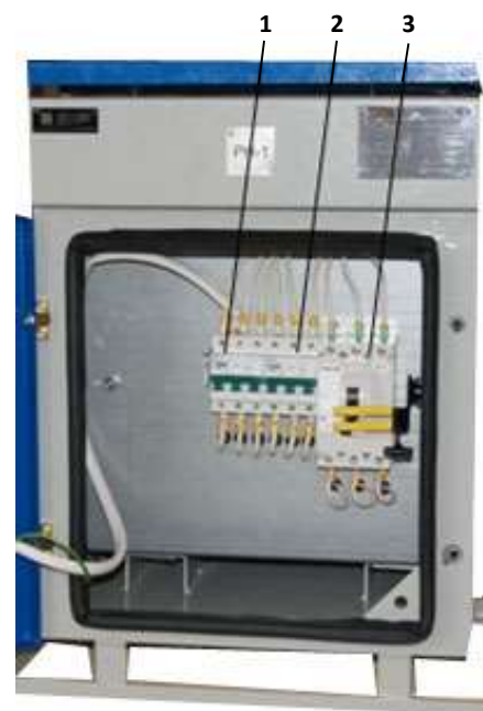
Рис. 13 Камера пускозащитной аппаратуры АОШ-2,5;5,0-3Ф (660/380-36 В) – напольное исполнение
