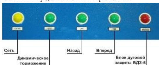
Рис.1 Индикация на двери РВВш-6.
