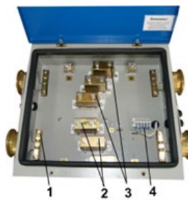
Рис. 9 Общий вид ВР-250Р-ПП (в корпусе повышенной прочности).
