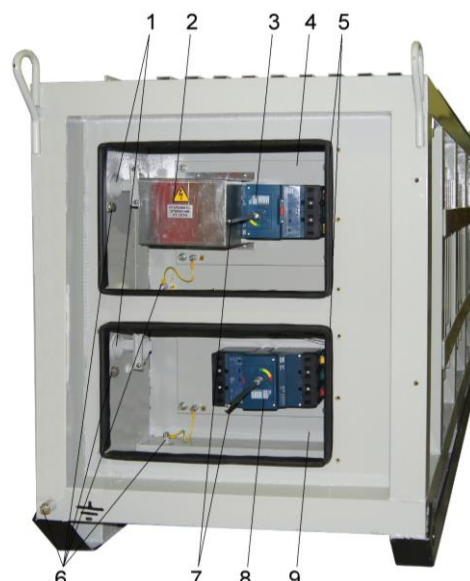
Рис. 5 Вид КТП-РП-ХХ-П01-0,69-0,4/0,23 с открытыми дверцами.
