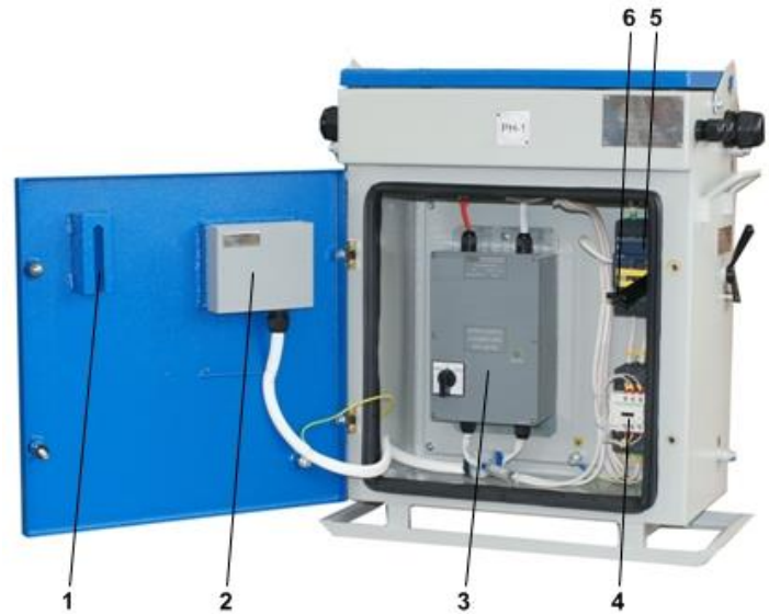
Рис. 2 Камера пускозащитной аппаратуры ПР-63М.
