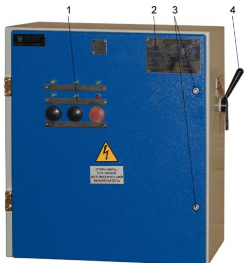
Рис. 2 Блок управления стрелочным переводом БУПС-1П.
