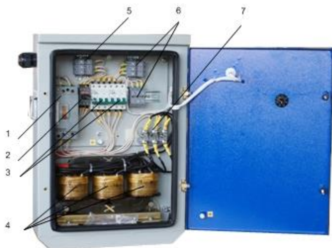
Рисунок 8 - Камера пускозащитной аппаратуры аппарата АОШ-0,8;1,6; (660-380/36 В)- навесное исполнение
