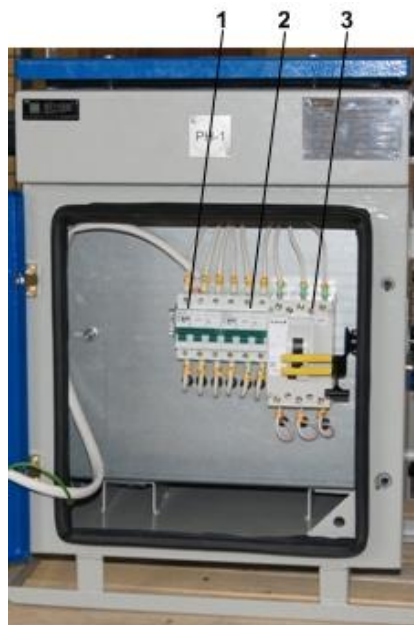
Рисунок 6 - Камера пускозащитной аппаратуры аппарата осветительного АОШ-2,5;5,0 (660-380/36 В)- напольное исполнение
