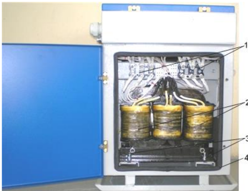
Рисунок 4 - Камера силового трансформатора
