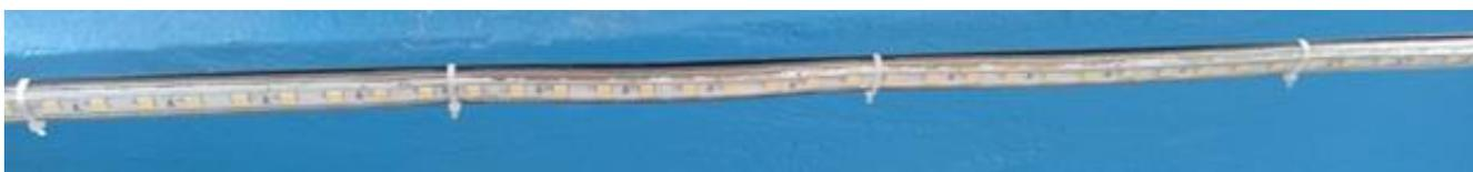
В горных выработках по всей длине, через каждые пять метров, монтируются подвесы светодиодной ленты. Согласно проекта может быть несколько вариантов организации светодиодного освещения, например:
