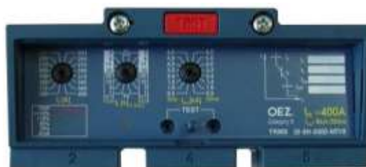
Рис. 16 Панель электронного расцепителя.
