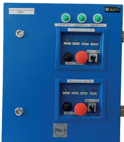
Пульт заливочных насосов ПЗН-2 (на два насоса)
