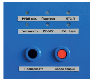
Рис. 7. Панель ПСУ-1ТП (КТП-РН-100...1250-10)/0,69-0,4-ДО-IT).
