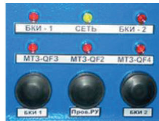
Рис. 6. Панель сигнализации и управления ПСУ-5АП.
