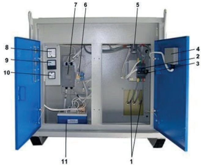
Рис. 5. Вид КТП-РН-П-25-6(10)/0,69-0,4 со стороны РУНН с открытыми дверцами.
