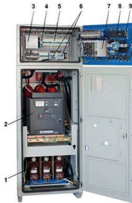
Рис. 4. Шкаф вводной с открытой дверью.
