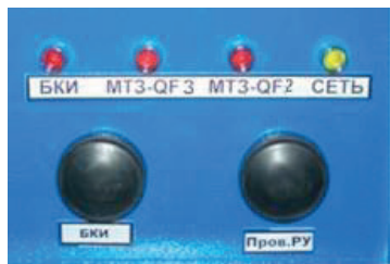
Рис. 5. Панель сигнализации и управления ПСУ-2АП.
