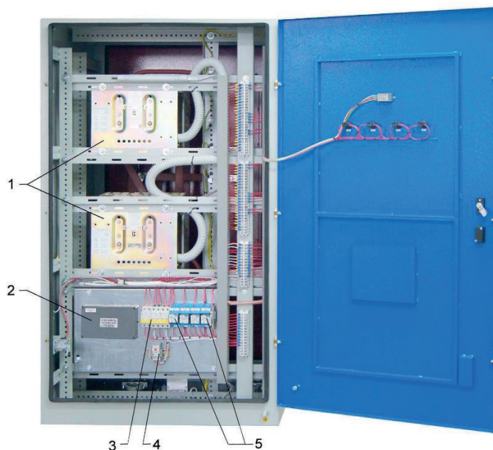
Рис. 2. Шкаф КРУ-РН-6-ВК-2x400 Вид спереди с открытой дверью
