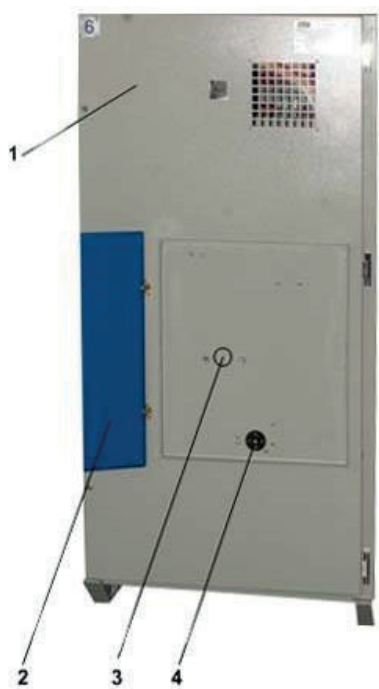
Рис. 11. Шкаф секционного разъединителя вид сзади.
