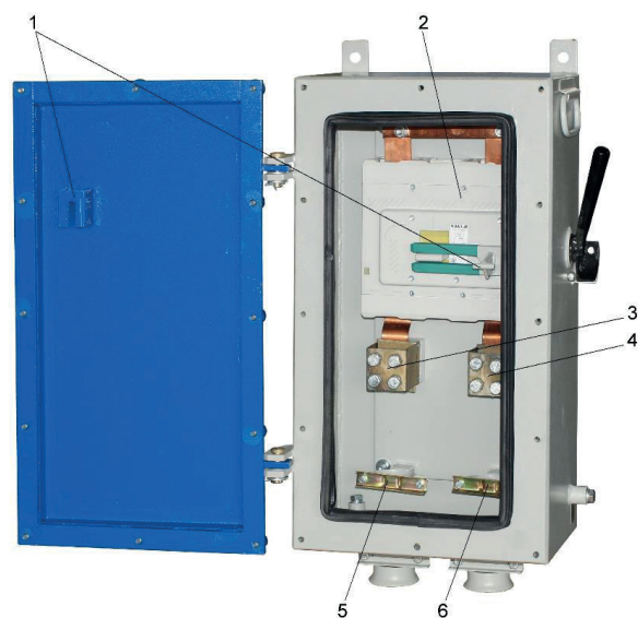
Рис.6. Выключатель ВАРП-500Р-ПП с открытой дверцей/
