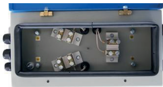
Рис. 7. Камера вводов/выводов аппарата осветительного однофазного АОШ-1Ф-1,6-660-380/220(127) В с открытой крышкой.
