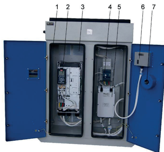
Рис. 2. Пускатель ПРЧ с открытыми дверцами.
