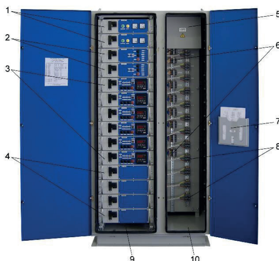
Рис. 3. Станция СУЭП-100-2-14 с открытыми дверцами.
