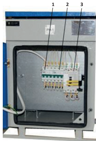
Рис. 13. Камера пускозащитной аппаратуры АОШ-2,5;5,0-3Ф (660/380-36 В) – напольное исполнение.
