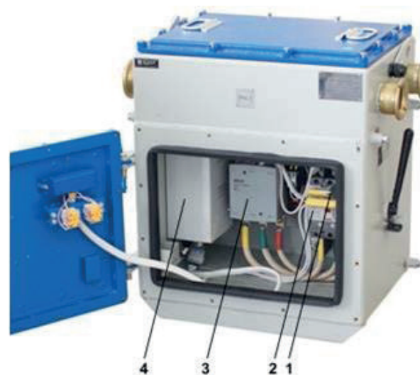
Рис. 11. Камера пускозащитной аппаратуры ПР-160ПП.
