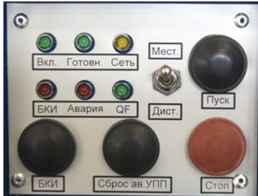
Рис. 9 Панель сигнализации и управления
