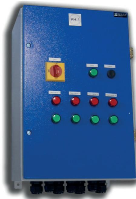
Рис.7 Блок управления светофорами БУС
