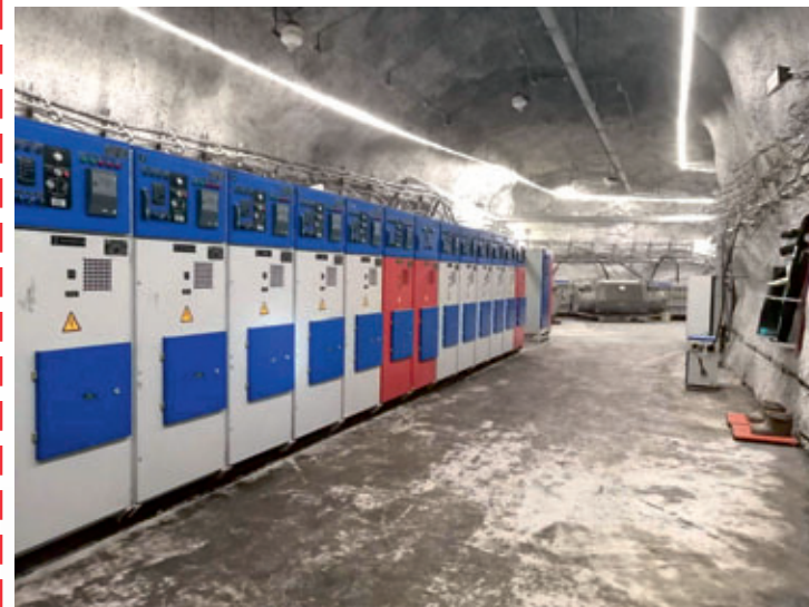
Комплектные распределительные устройства КРУ-РН ( Кировский рудник ОАО "Апатит")
