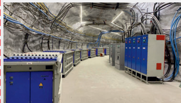
Комплектные трансформаторные подстанции КТП-РН ( Кировский рудник ОАО "Апатит")
