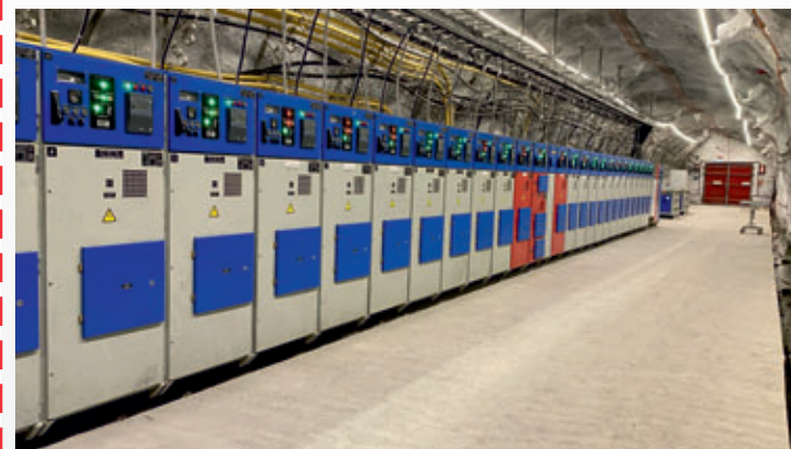
Комплектные распределительные устройства КРУ-РН ( Кировский рудник ОАО "Апатит")
