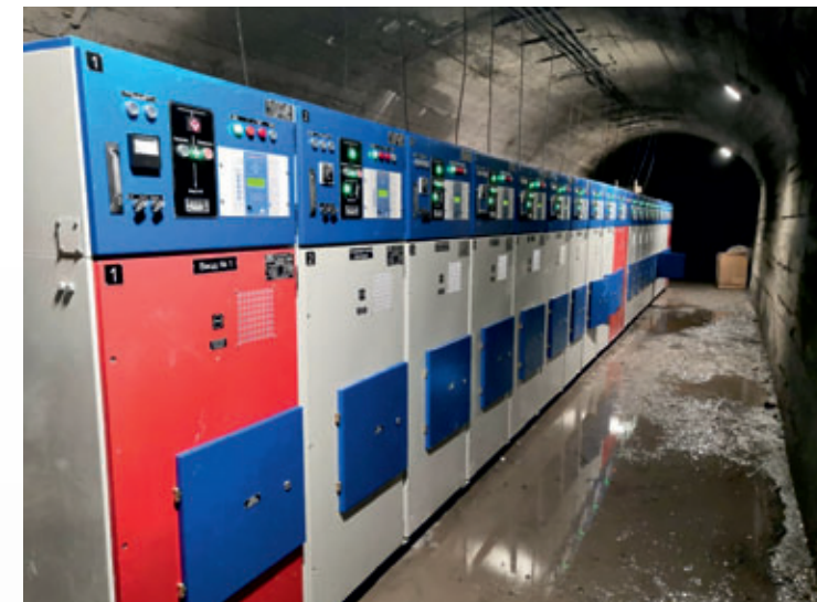
Комплектные распределительные устройства КРУ-РН ( Яковлевский рудник, ПАО «Северсталь»)
